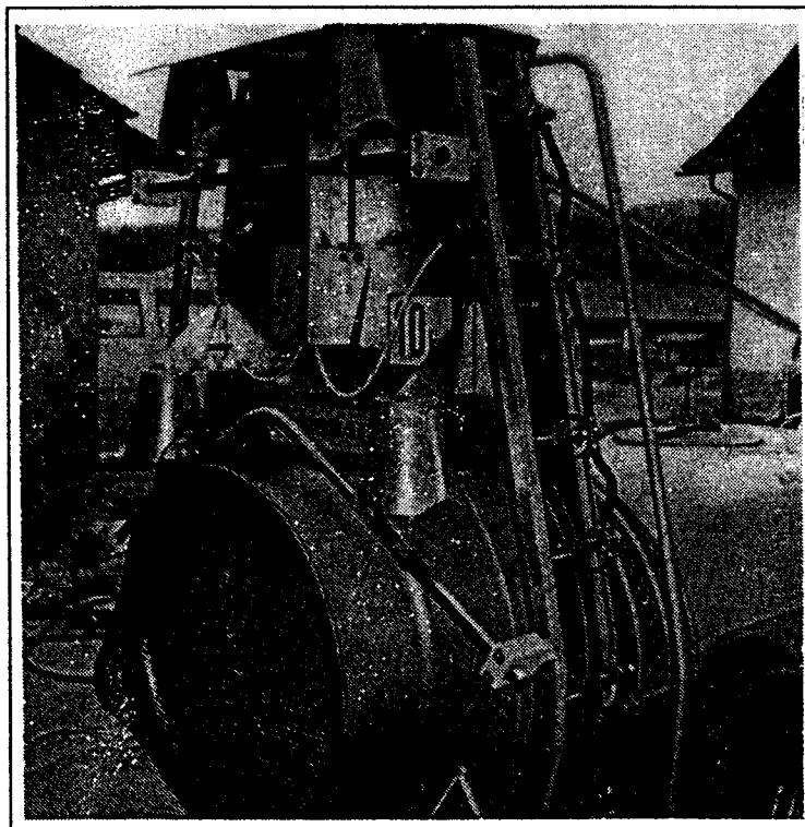
Abb. 4: Sprühgerät mit Influenzaufladung von Spritzmitteln
